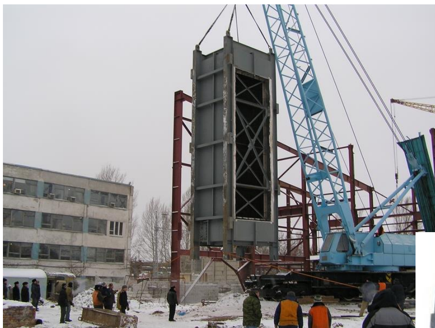
HRSGを鉄道クレーンで据付
