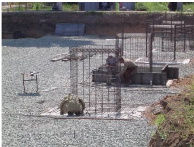
HRSG基礎工事
