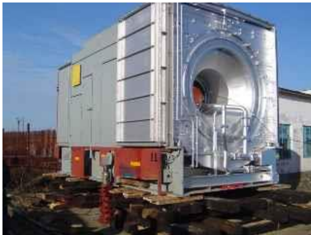
ジャッキアップにてトランスポートに積みこみ
