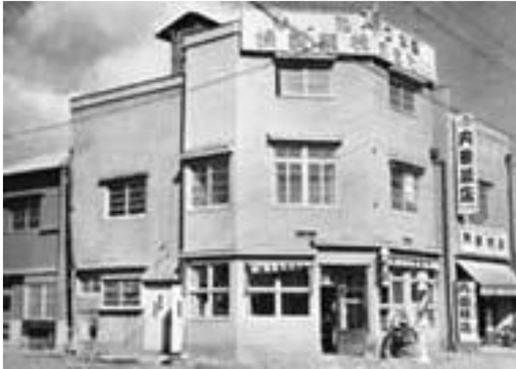
八丁堀にあった3階建て理髪店兼自宅
